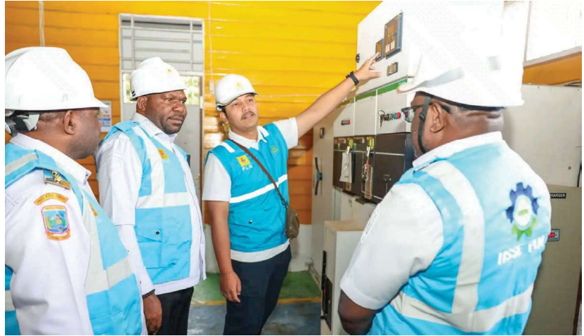
★ Gubernur Papua Tengah Meki Fritz Nawipa didampingi Bupati Intan Jaya Aner Maisini saat meninjau proyek kelistrikan yang dilakukan oleh PT PLN (Persero), Rabu, 9 Juli 2025 di Sugapa.
